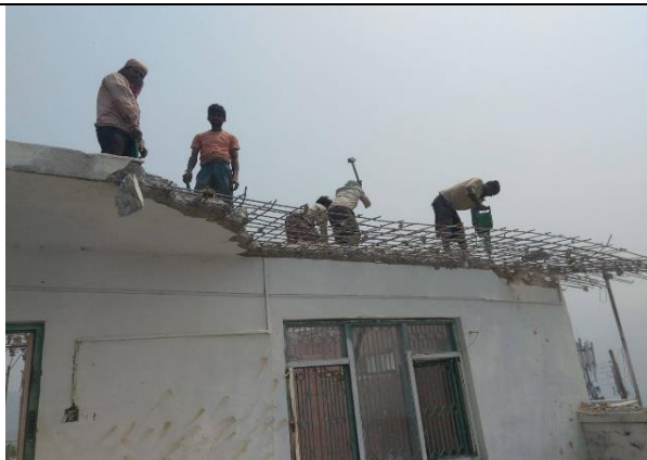
Afbreken van het beschadigde Gaurishankar Hospital
