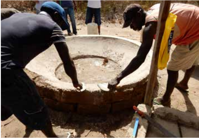
het boetseren van de holle ronding van de mal
